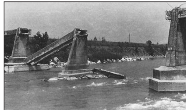
Il vaso "Canalone" che attraversa il fiume Chiese presso Borgosotto, distrutto dalla grande piena il 3 ottobre 1976. (Foto tratta dal libro Storie d'acque, di terre e di uomini - Medio Chiese)
